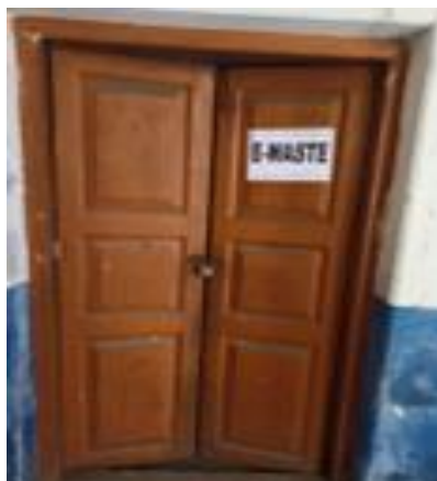
Fig: E-waste room
